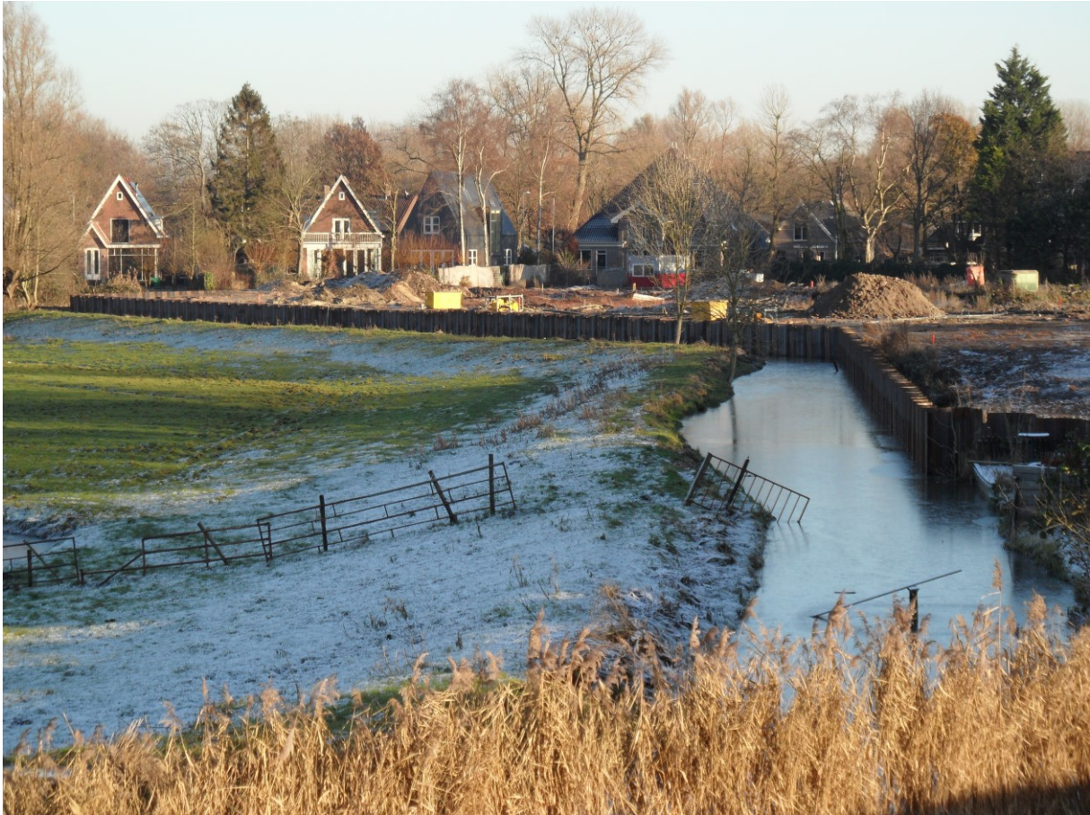
Figuur 2.1 Nieuwe damwand rond het voormalig bedrijfsterrein Kiekens, nu Klein Kadoelen
