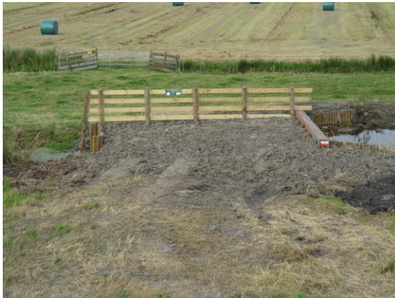
Figuur 3.10 Nieuwe duiker in de aarden dam in de kwelsloot; links: niet beweegbaar hek op de aarden dam, rechts: houten damwand met opening naar duiker en regelbare overlaat
