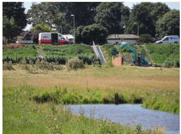
Figuur 3.11 Links: schonen kwelsloot (12 okt.); rechts: stalen trap op dijktalud, plaatsen houten damwand (22 juli)
