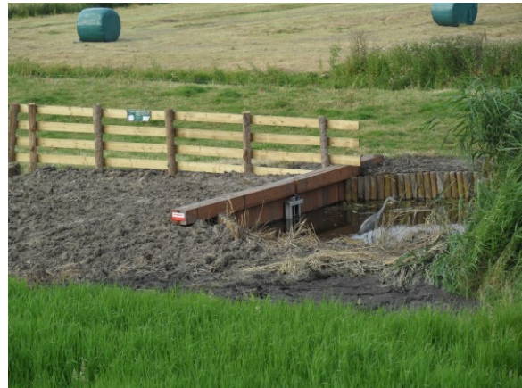
Figuur 3.10 Nieuwe duiker in de aarden dam in de kwelsloot; links: niet beweegbaar hek op de aarden dam, rechts: houten damwand met opening naar duiker en regelbare overlaat
